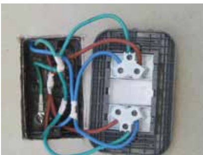
Figura 2. Bien. Ejemplo de conexión adecuada en módulos de tomacorrientes y adecuada conexión del conductor de protección.
