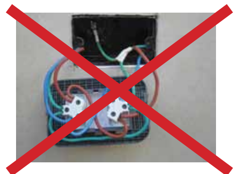
Figura 1. Mal. Ejemplo de conexión inadecuada que puede generar sobrecargas en los bornes del tomacorriente, a la vez que no brinda una adecuada conexión del conductor de protección.
