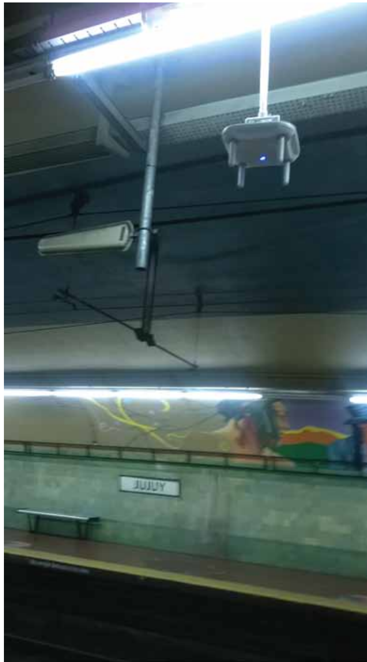
Antena y router en estaciones de subte
