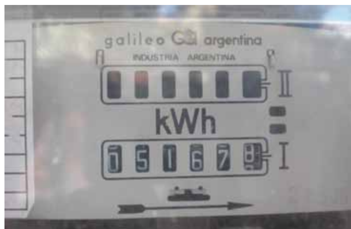
Medidor con doble numerador tal como se lo usa actualmente con su segundo numerador cegado.
